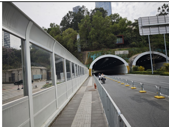
隧道进口左侧声屏障
