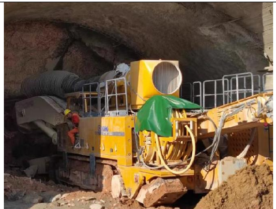
隧道机械开挖（免振动爆破）
