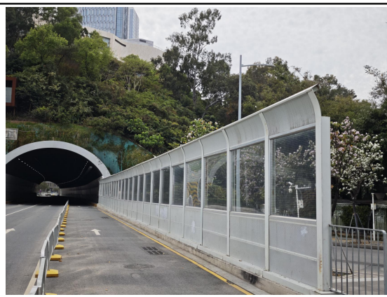
隧道进口右侧声屏障
